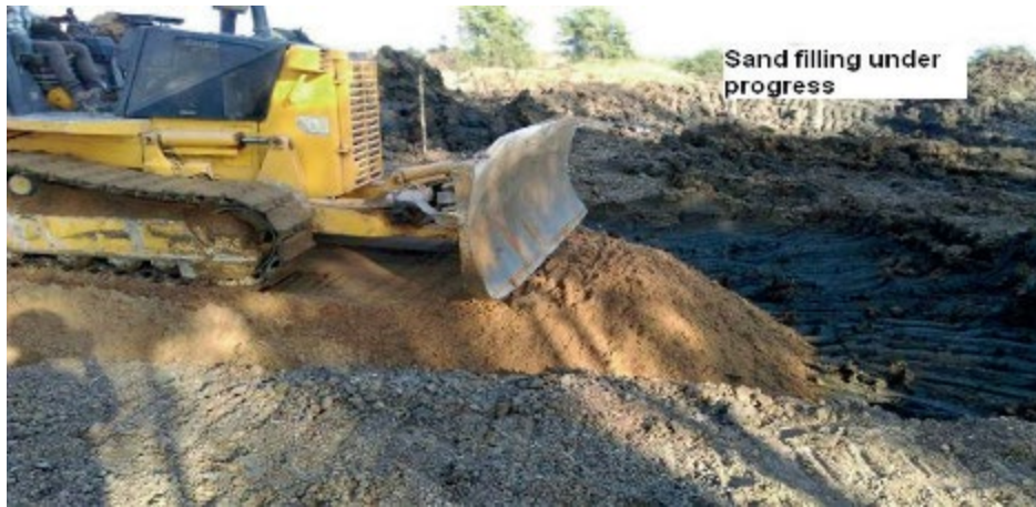
图 111. 沙层的铺设（图片由帕拉迪普公司提供）
