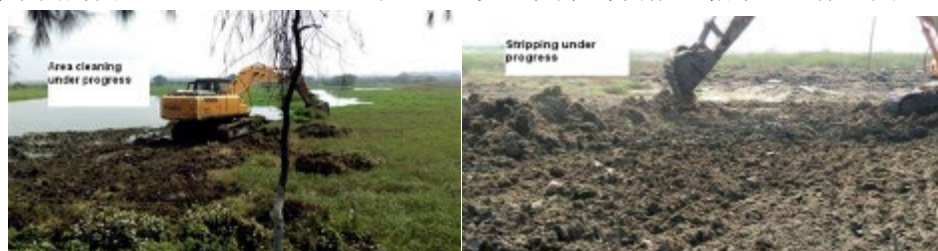
图 110. 清理 (左) 和去土 (右) 现场 (图片由帕拉迪普公司提供)
