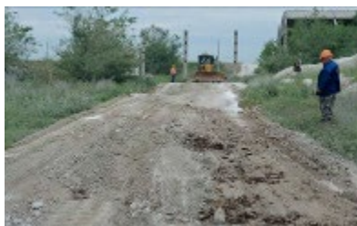
图 90.准备用于铺设 RBPG 的地基 （图片由 PhosAgro 公司提供）
