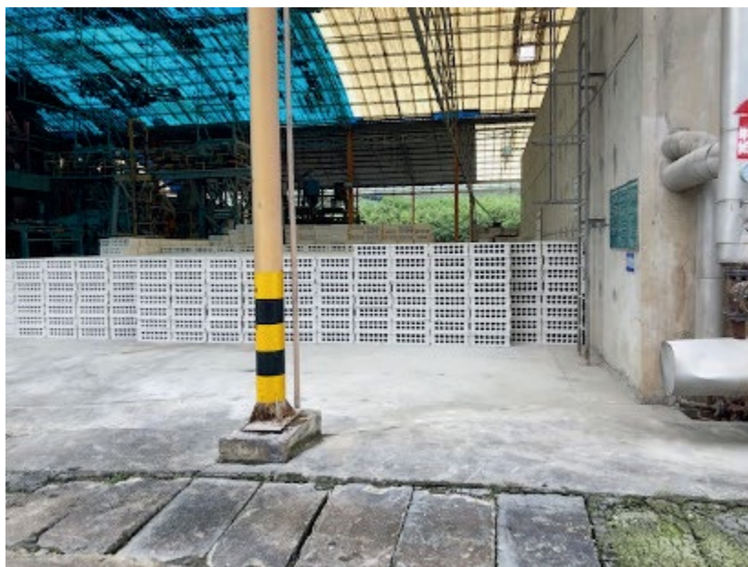
图 87. 利用磷石膏制备的建筑用砖块（图片由国际肥料协会秘书长 Charlotte Hebebrand 女士提供）
