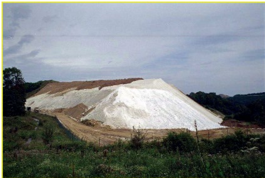
图 84. 磷石膏临时存储堆[8] - 侧翼裸露，以吸引新的植物物种或重建已有的植物物种群落，从而促进生物多样性
