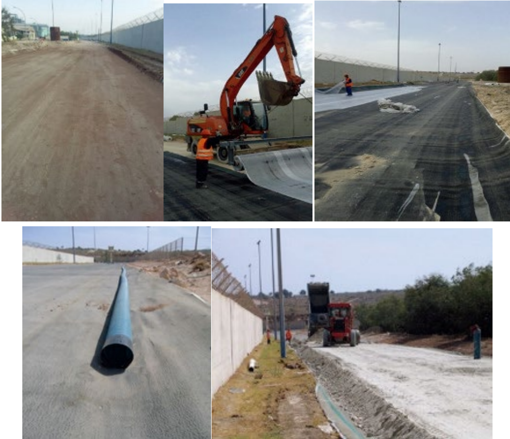
图 105. 在萨菲道路建设中，使用防渗膜覆盖在天然土壤层和用于收集径流水的排水系统上（图片序列由 OCP 提供）
