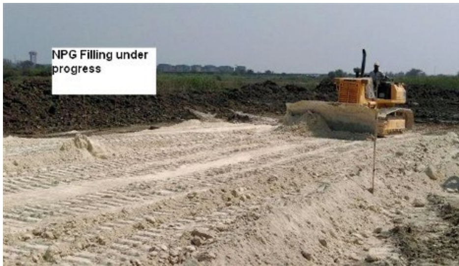
图 112. 使用中和磷石膏（NPG）建造路堤（图片由帕拉迪普公司提供）
