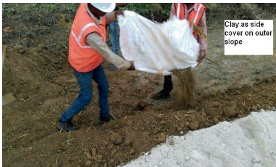
图 113. 使用黏土修建道路的侧面和外坡（图片由帕拉迪普公司提供）
