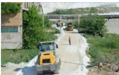
图 95.铺展和压实砾石层 （图片由 PhosAgro 公司提供）
