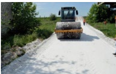
图 94.用轻型压路机压实 RBPG 层（图片由 PhosAgro 公司提供）
