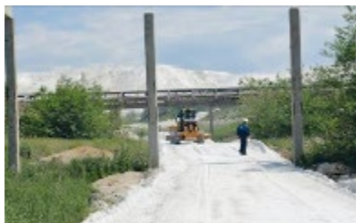
图 93.用平地机平整道路地基（图片由 PhosAgro 公司提供）
