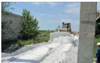
图 92.用推土机散播 RBPG（图片由 PhosAgro 公司提供）
