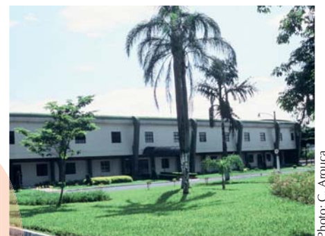
Fosfertil - Cubatão Industrial Complex
